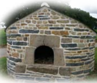
Reflet de la géologie locale très variée, la maçonnerie de ce four est composée de schiste et de grès, avec gueule en granite.
