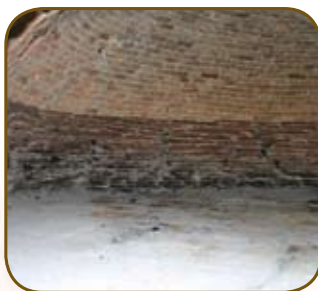
Généralement entièrement en brique, la voûte est parfois composée d'une maçonnerie de pierre, ici schiste pourpre local.
